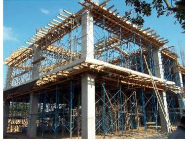
**Gambar 5. 73 Struktur Beton Bertulang**
