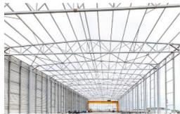
**Gambar 5. 80 Struktur Besi Pipa**
